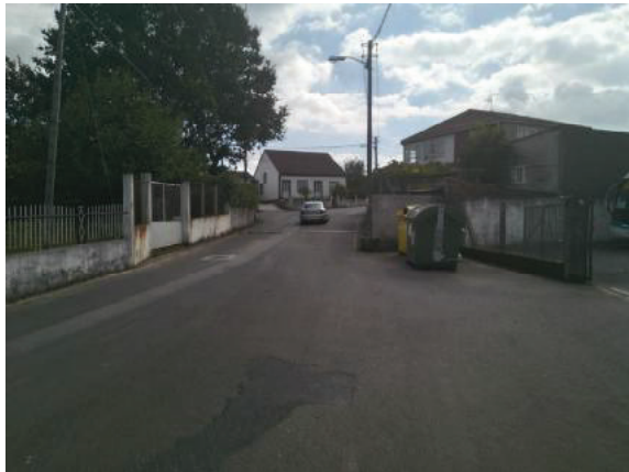
Fotografía 4. Rúa Cascaleira, en el tramo comprendido entre rúa del CEIP y el cruce de la carretera CP-8202.
